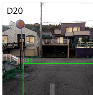
亀甲状ひび割れ
